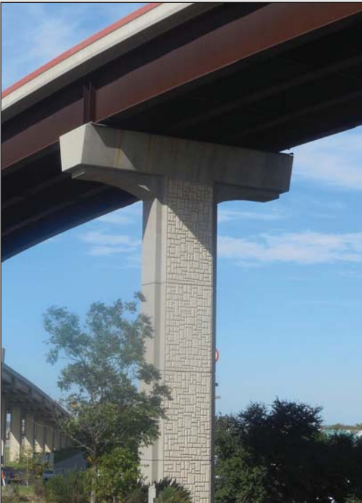
Fig. 2.1- Hammerhead Bent
