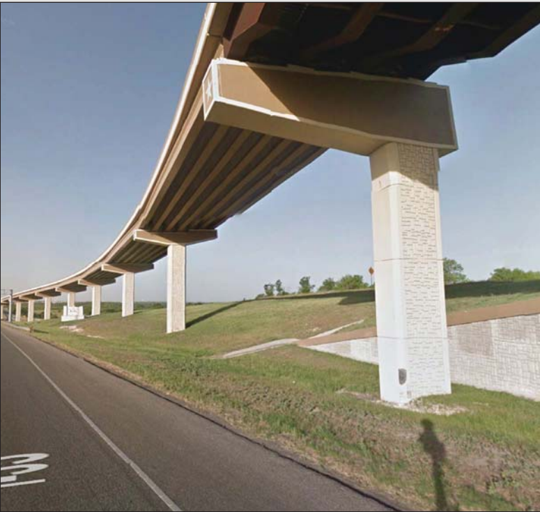
Fig. 4.6- Cantilever Bent
