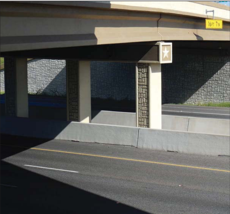
Fig. 4.2- Multi-Column Bent
