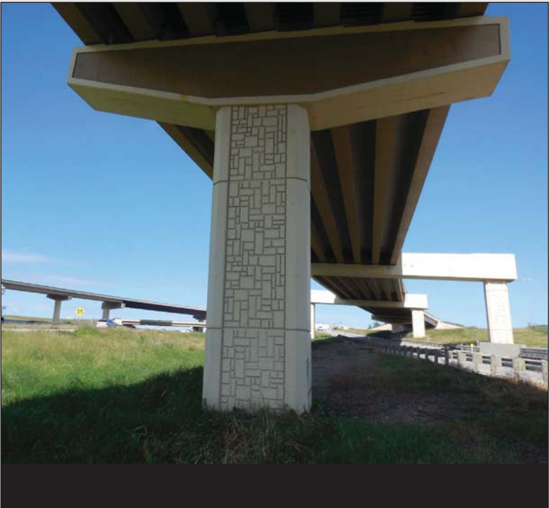
Fig. 4.1- Hammerhead Bent
